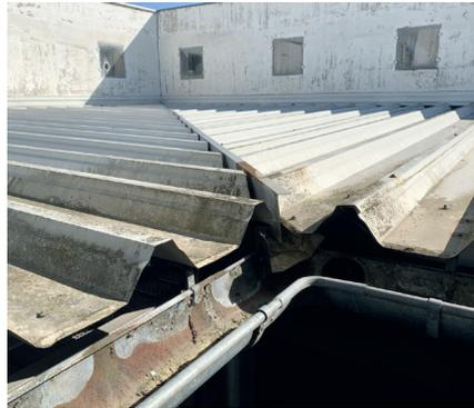
Eine weitere Schwachstelle sind die Wasserableitungen. Das Regenwasser der Dachrinnen wird in das Innere des Obergeschoßes abgeleitet. Bei starkem Regen können die Abwassergullys die große Wassermenge nicht ableiten, dadurch kommt es zu stehendem Wasser am Asphalt.
